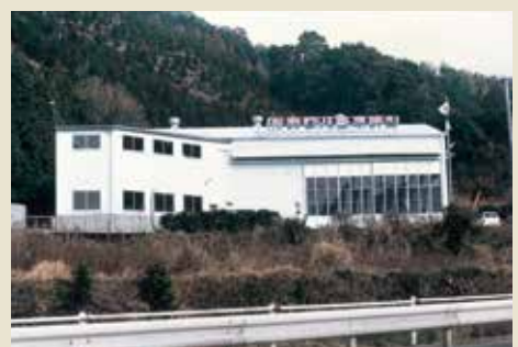
カワハラネオン広告 新工場 平成元年3月竣工
